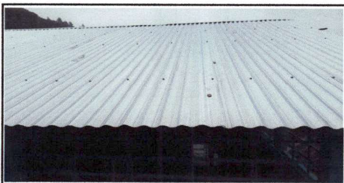
Foto 6: Finalización de sustitución de lamina troquelada calibre 28
