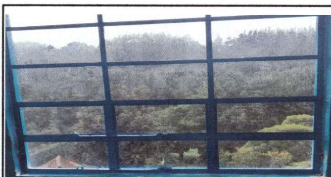
Foto 4: Finalización de sustitución de ventanas de madera por metal.
