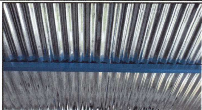
Foto1: Finalización de sustitución de lamina troquelada calibre 28
