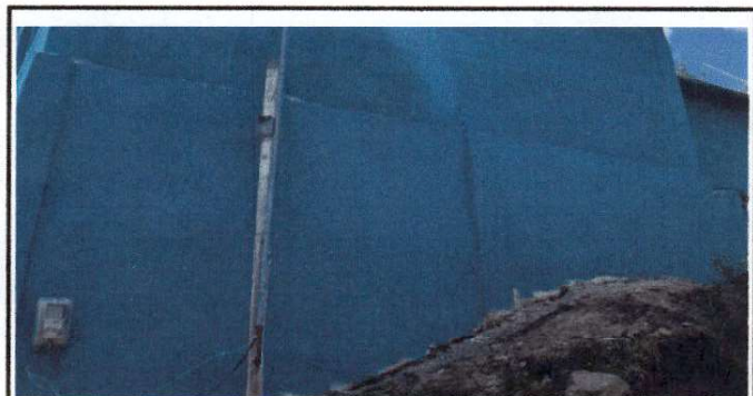
Foto 5: Finalización de reparación de muro perimetral de block.
