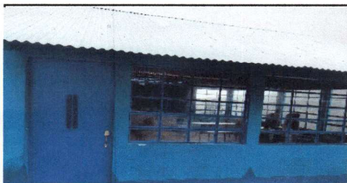
Foto 3: Finalización de sustitución de puerta.
